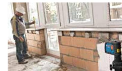
Transferencia de puntos para trabajos de nivelación
