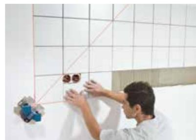
Base metálica para facilitar la instalación de azulejos y posicionar el láser donde es necesario
